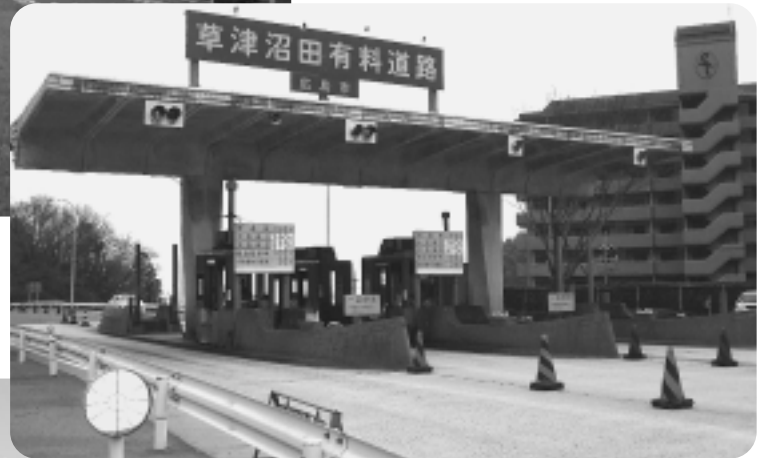
▼草津沼田有料道路入口付近
