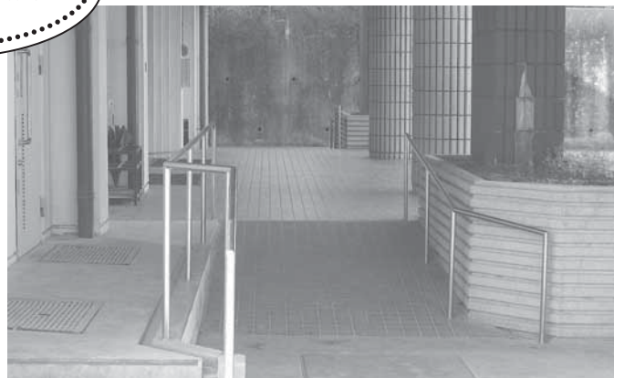
▲ スロープの手摺り改修(グラウンド側から撮影)
