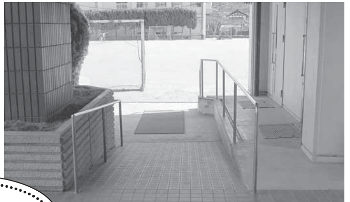
▲ スロープの手摺り改修(体育館側から撮影)
