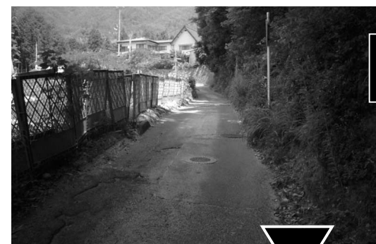
河内地区道路整備工事 工事着手前
